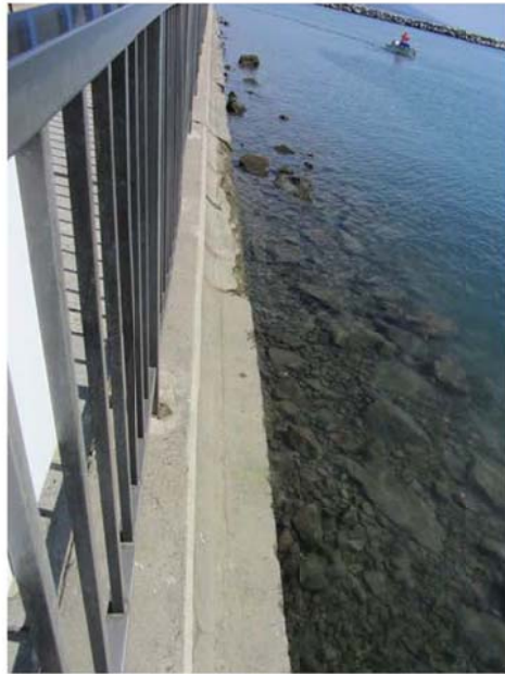
a. Type 1 Seawall
